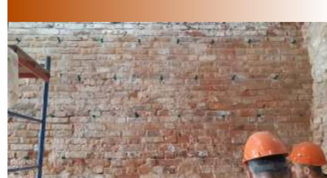
Инъецируемая суспензия за счет тонкого помола и ряда добавок способна эффективно проникать в имеющиеся в кладке поры и трещины, заполнять пустоты и места разрушенного кладочного раствора.
